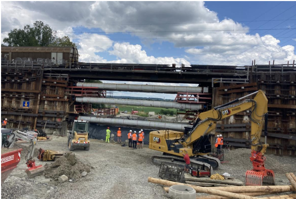
Verbau für den Bau der Eisenbahnüberführung in Wernhardsberg (Foto: DB E&C Ziller)
