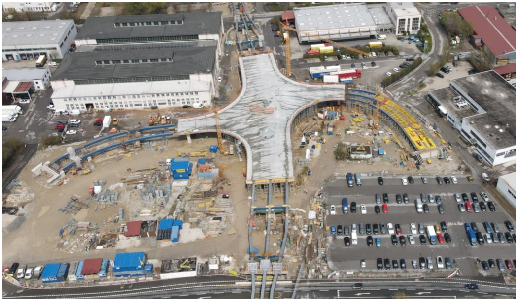
Bau der Aicherparkbrücke mit obenliegender Anschlussstelle (Foto: Schellmoser)
