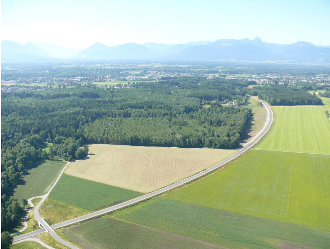
Bauabschnitt 3.1: Luftbild vom Juni 2023 in Blickrichtung Süden mit BW 7.1 (Foto: Schellmoser)
