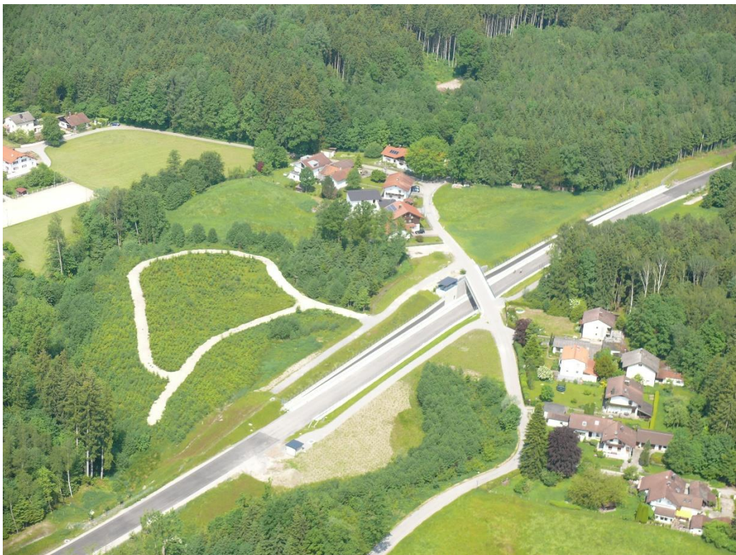
Bauabschnitt 3.1: Luftbild vom Juni 2023 des Lärmschutztrogs Großholzstraße (Foto: Schellmoser)
