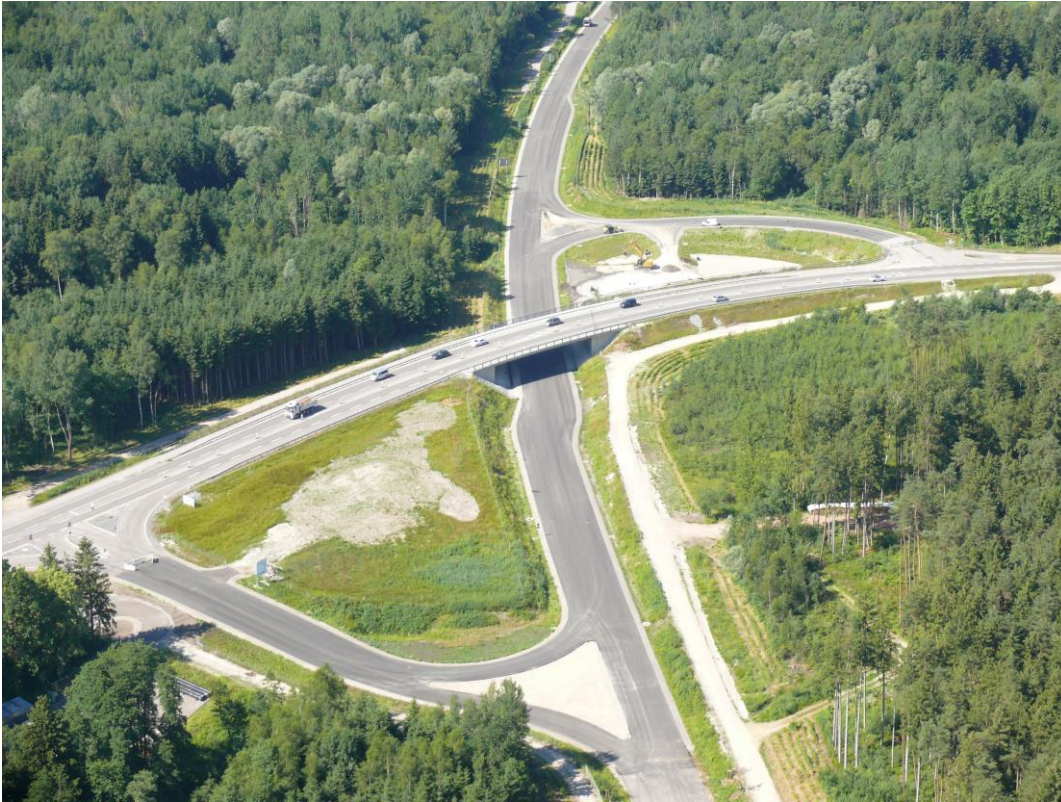
Bauabschnitt 3.1: Luftbild vom Juni 2023 der Anschlussstelle RO 19 (Foto: Schellmoser)
