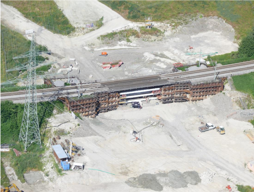
Bauabschnitt 3.2: Luftbild vom Juni 2023 der Bahnbrücke Wernhardsberg (Foto: Schellmoser)
