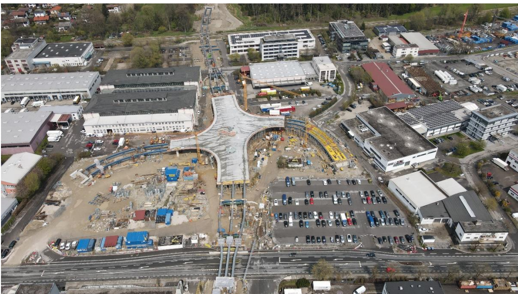
Luftbild vom April 2021: Beginnender Betonüberbau an der AS Aicherpark (Copyright: Schellmoser)
