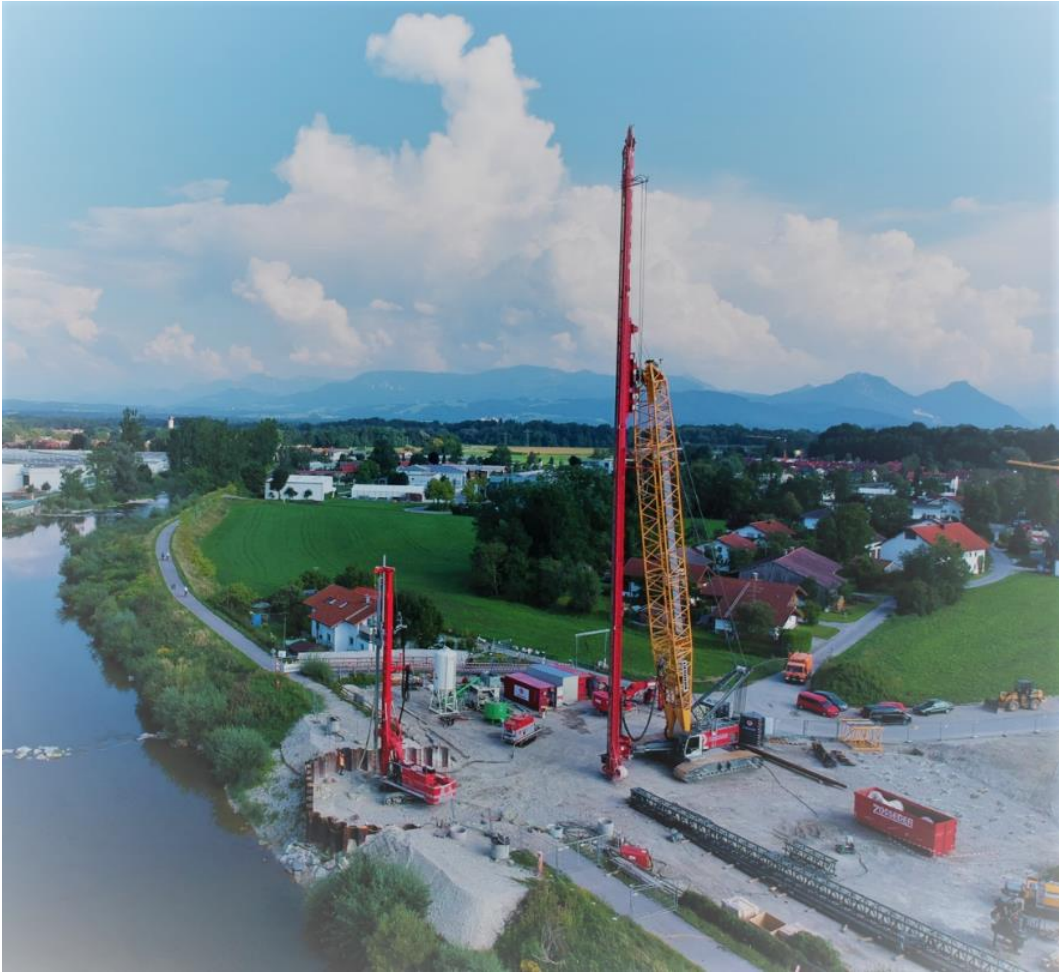
Großgerät der Fa. Menard (rechts) für Einbringung der Vertikaldrainagen. (Copyright: HABAU Hoch- und Tiefbaugesellschaft mbH)
