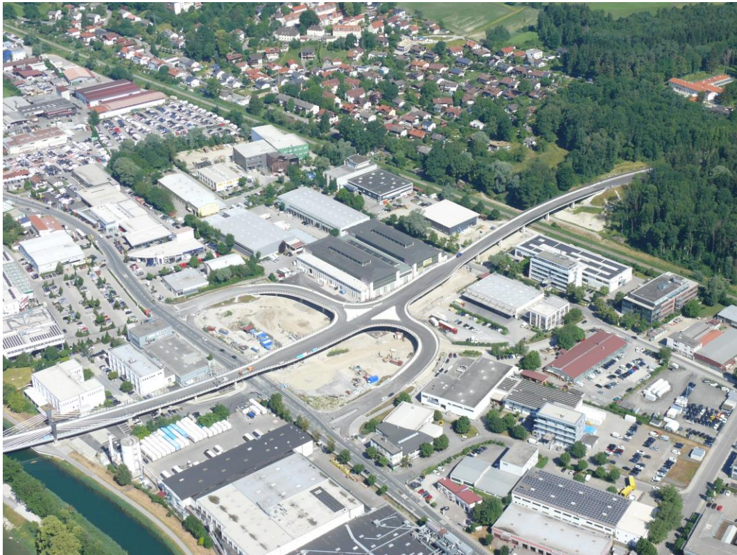
Luftbild vom Juni 2023: Aicherparkbrücke im Bau (Copyright: Schellmoser)
