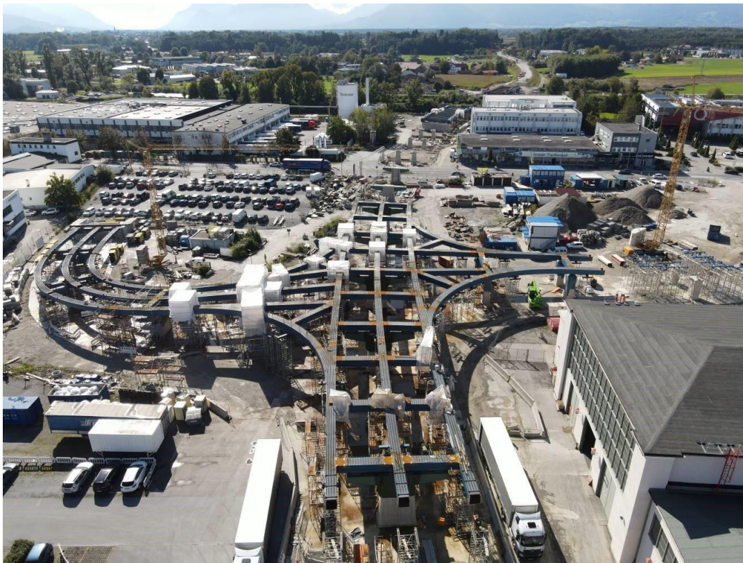
Luftbild vom Herbst 2020: Stahlbau an der AS Aicherpark (Copyright: Habau)
