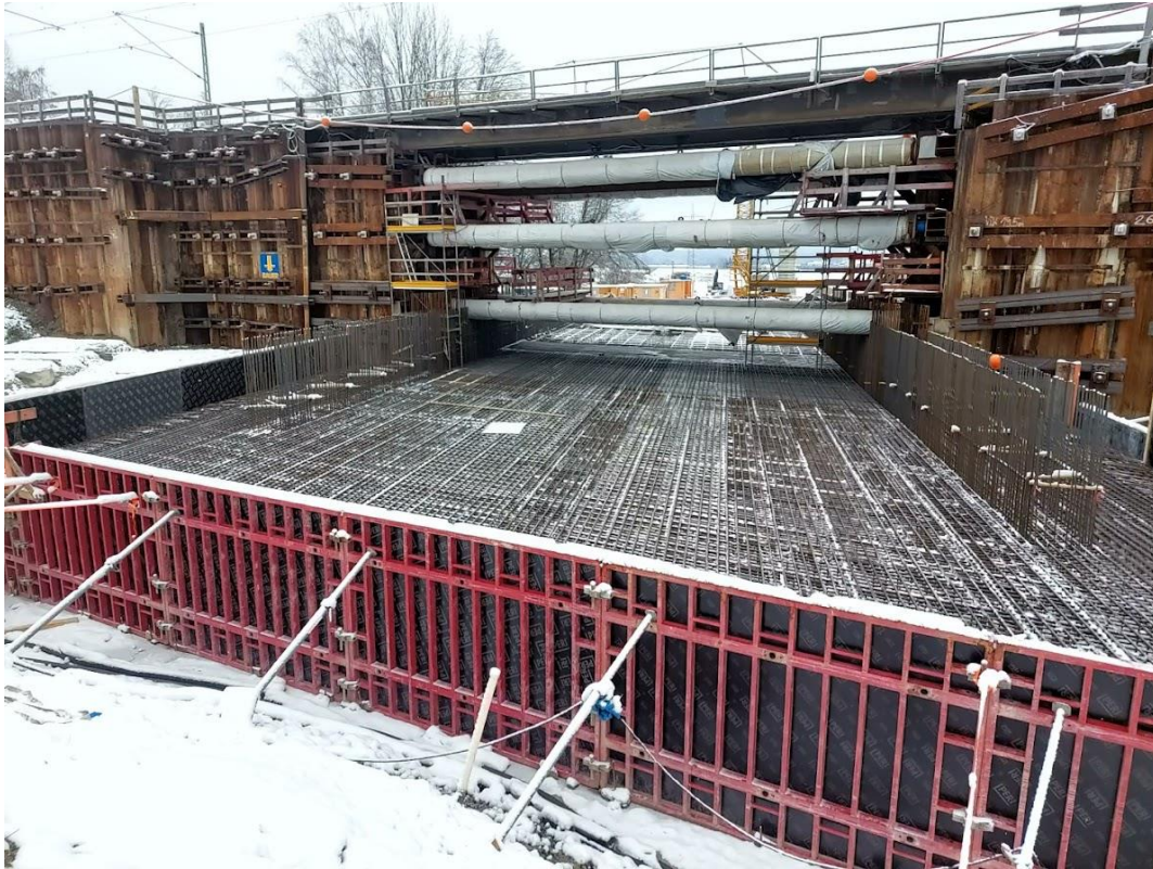
Aufnahme vom Januar 2024: Bewehrungsarbeiten an der Bodenplatte
