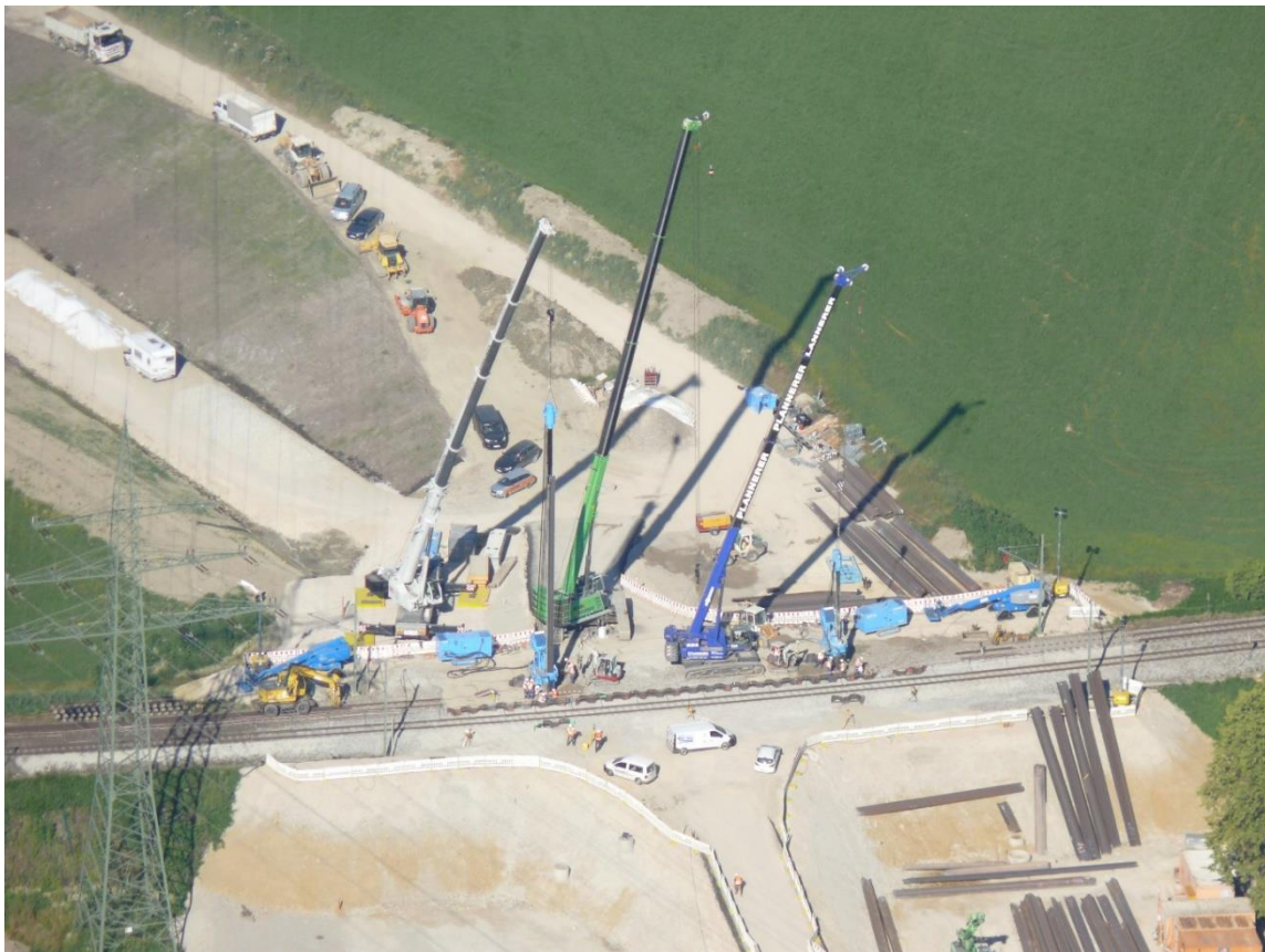
Luftbild vom 30.6.2019: Einbringen der Spundwandsicherung (Copyright: Schellmoser)
