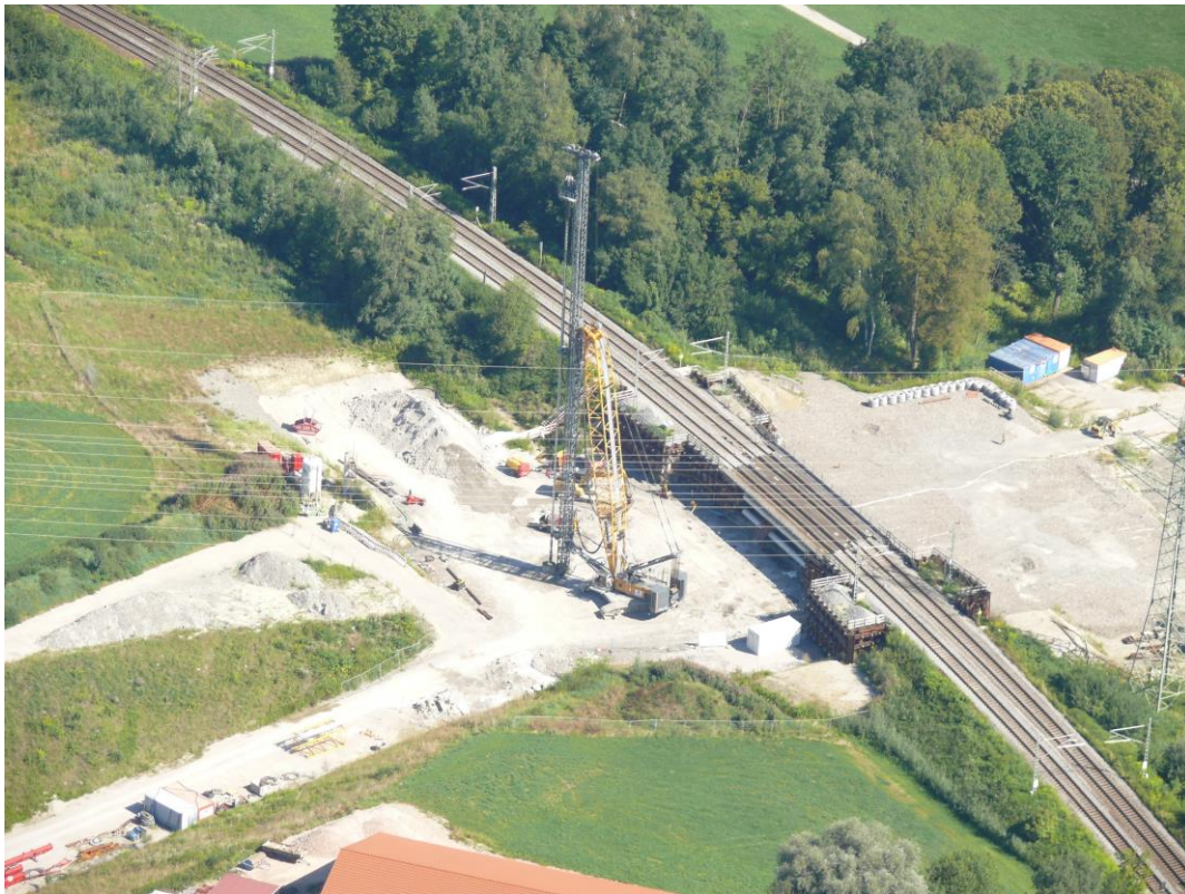
Luftbild vom August 2022: Herstellung der Spezialgründung (Copyright: Schellmoser)
