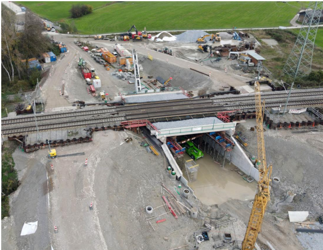
Luftbild vom Oktober 2024: Die Brückenhälften sind bereit für den Einschub.
